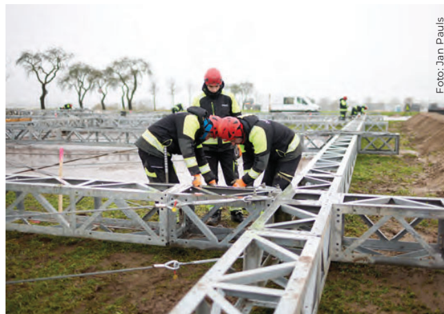
Erster Mast für Provisorium wird errichtet
